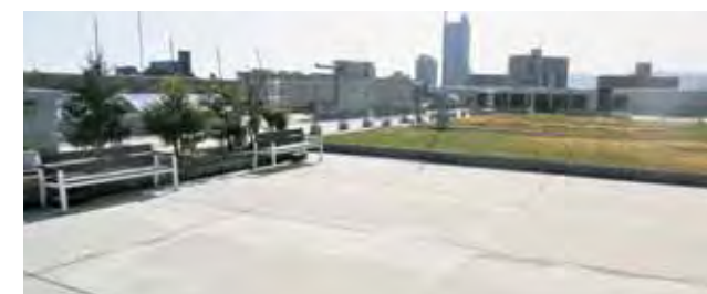
緑化により、憩いの空間としても使われている屋上
