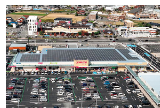
カーボンニュートラルなガスを使用する 「ゆめマート西条」
