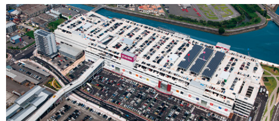
屋上で太陽光発電を行う 「ゆめタウン光の森」
