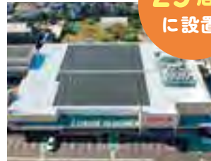
「ゆめマート五日市」の太陽光発電パネル
